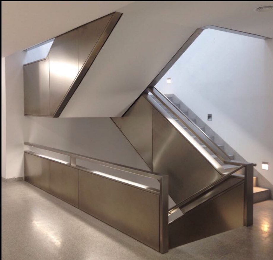
BARANDILLA DE ACERO INOXIDABLE EN TRAMO DE ESCALERA
