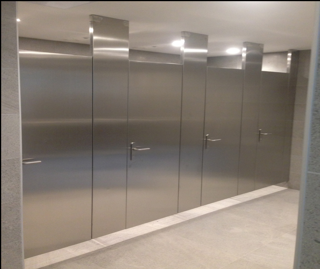
CABINA DE ACERO INOXIDABLE DESCOLGADA DEL FALSO TECHO
