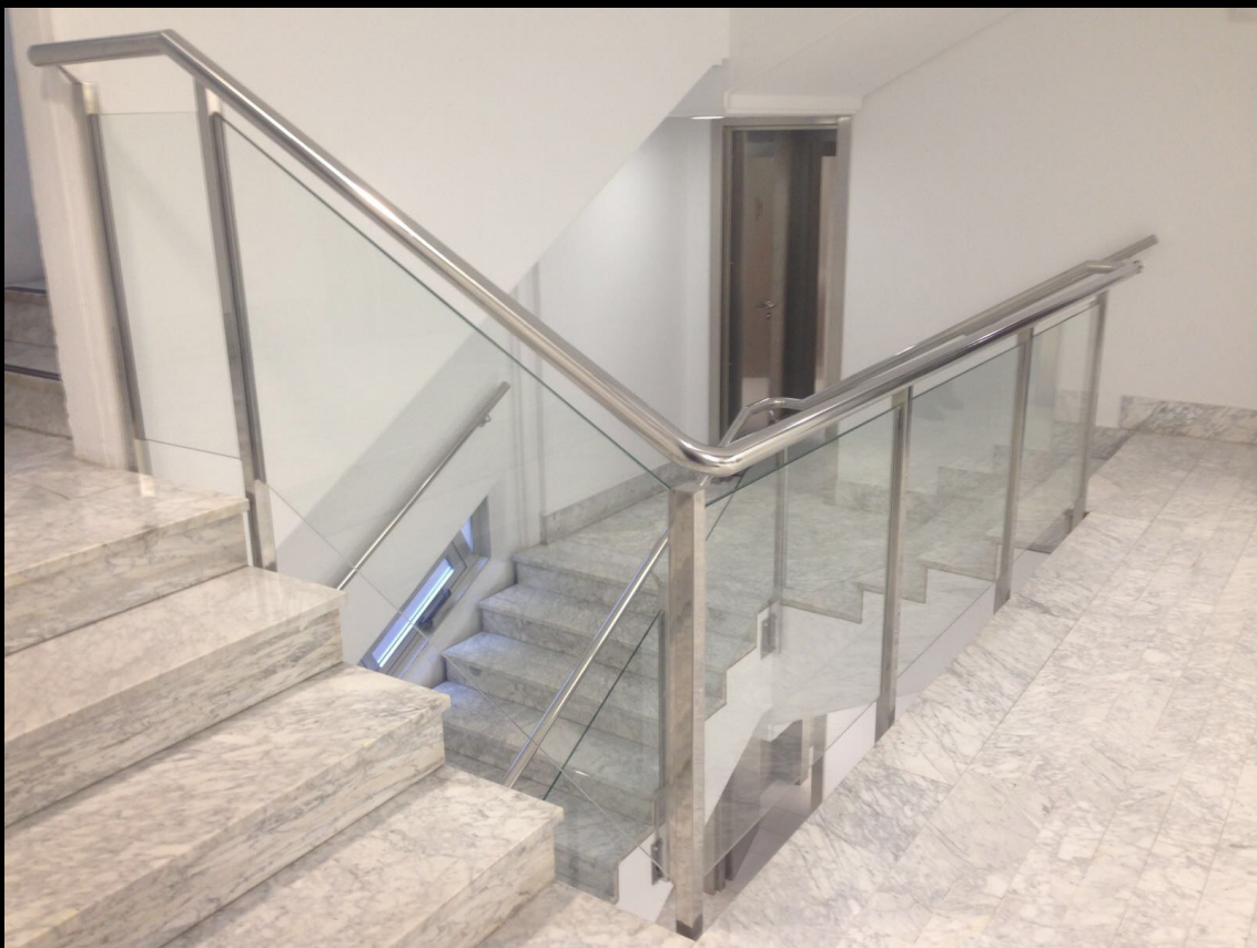
BARANDILLA DE ACERO INOXIDABLE + VIDRIO EN TRAMO DE ESCALERA
