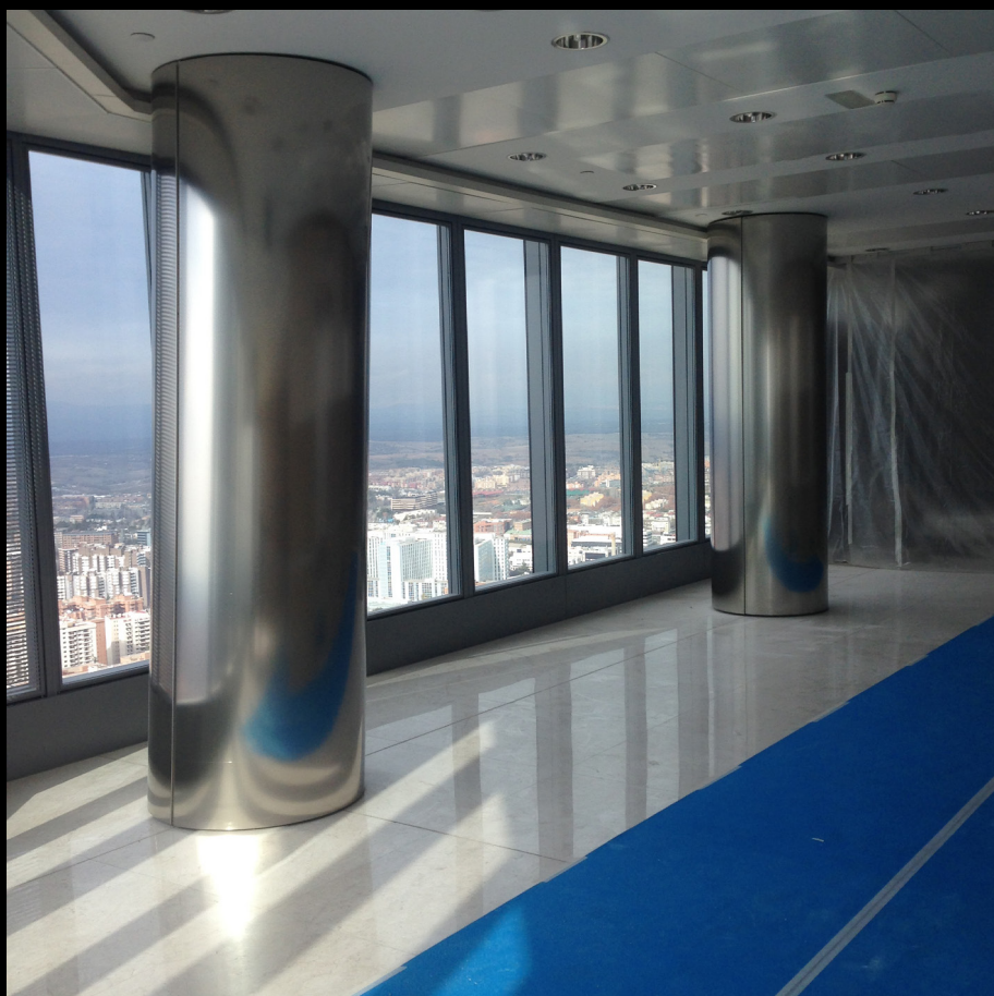
PILARES CIRCULARES DE ACERO INOXIDABLE INCLINADOS
